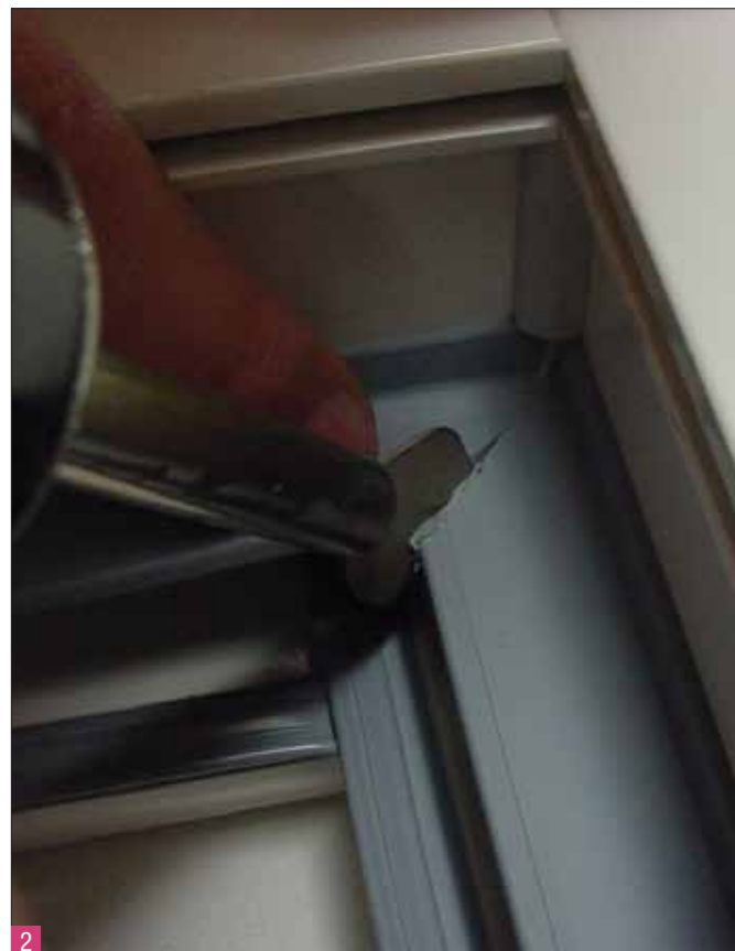
Передняя часть уплотнений расплавляется при температуре ок. 400 °С в течение 3 сек.
